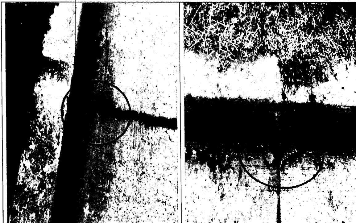
Fotografía N° 5. Juntas transversales sin prolongación al borde de la solera en calle los Pellines.
